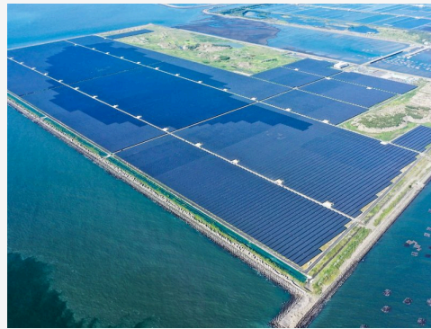
272MW E2 I Yunlin Xinxing Power Plant
